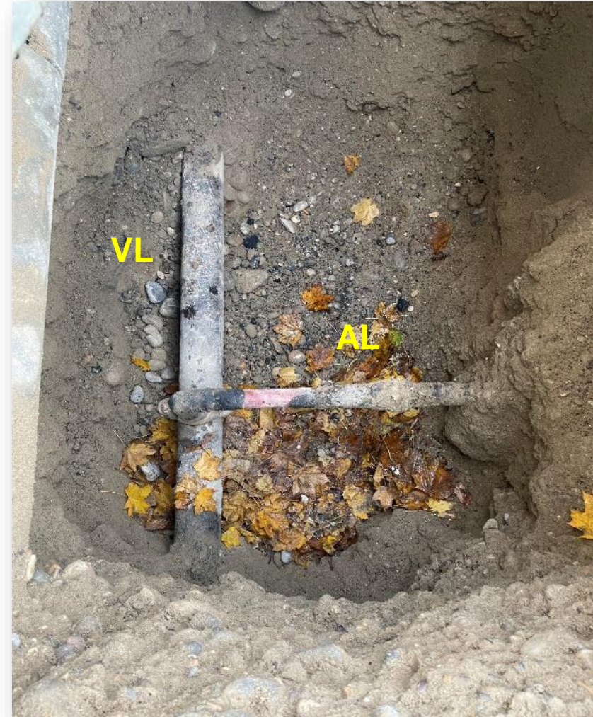
VL = Versorgungsleitung Erdgas AL = Anschlussleitung Erdgas
